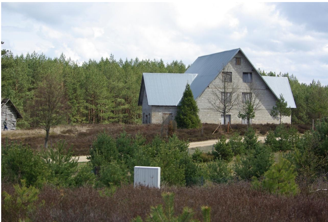
Fot. 1 Widok na sąsiadującą zabudowę mieszkaniowo zagrodową z terenu projektu planu
